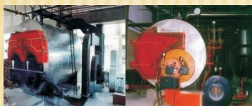
Caldera tubo de fuejo aceite y combustible sólido
