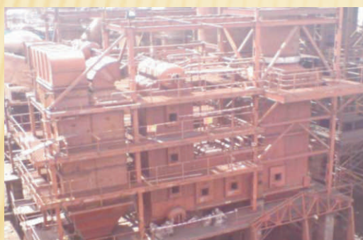
Caldera de recuperación de calor residual (escape del horno)
