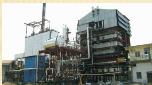
Caldera de combustión con fluido para carbón
